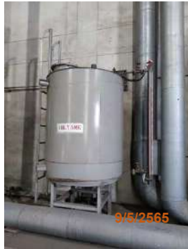
รูปที่ 2-66 Emergency Gravity Oil Tank
