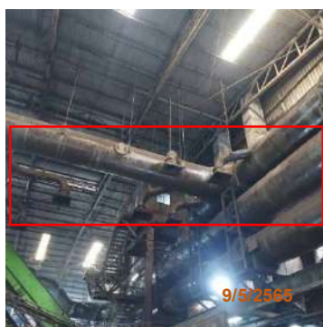
รูปที่ 2-73 พัดลมดูดอากาศในโรงผลิต RDF
