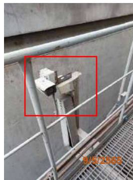
รูปที่ 2-61 การติดตั้งกล่องวงจรปิด สำหรับตรวจสอบระดับน้ำ ของหม้อไอน้ำ
