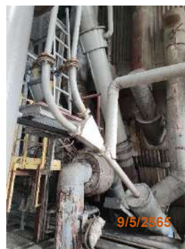
รูปที่ 2-10 ระบบ Limestone Injection
