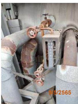
รูปที่ 2-64 เครื่องวัดระดับน้ำของหม้อไอน้ำ
