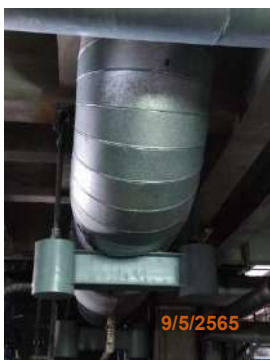
รูปที่ 2-38 ฉนวนกันความร้อนของ ระบบท่อไอน้ำ
