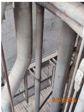
รูปที่ 2-60 Rapid Drain Piping System ของหม้อไอน้ำ
