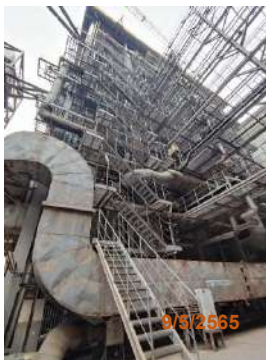
รูปที่ 2-54 CFBC Boiler ที่มีทางเดินและบันได พร้อมราวกันตก
