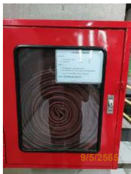
รูปที่ 2-44 ท่อดับเพลิงและตู้เก็บสายดับเพลิง
