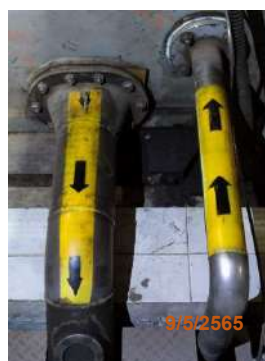
รูปที่ 2-65 ระบบท่อน้ำมันเลี้ยงแบริ่ง ของ Turbine&Generator
