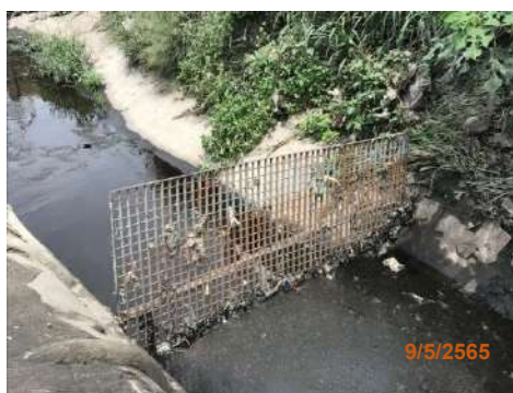
รูปที่ 2-26 ตะแกรงดักขยะมูลฝอย ก่อนระบายน้ำลงสู่ระบบบำบัดน้ำเสีย
