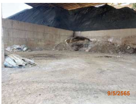
รูปที่ 2-36 สถานที่จัดเก็บกากของเสียที่มีหลังคาปิดคลุมและพื้นคอนกรีต
