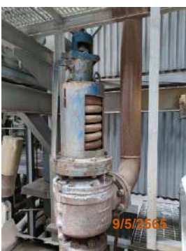
รูปที่ 2-56 Safety Valve ของหม้อไอน้ำ
