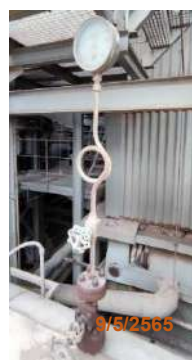
รูปที่ 2-57 Pressure Gauge ของหม้อไอน้ำ
