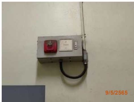
รูปที่ 2-43 ระบบสัญญาณเตือนอัคคีภัย (Fire Alarm)
