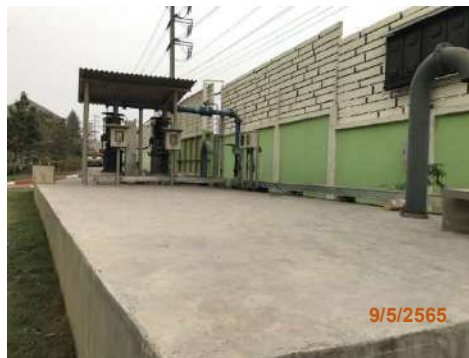
รูปที่ 2-24 บ่อปรับสภาพขนาด 1,000 ลบ.ม. (บ่อตั้งอยู่ใต้ดินมีบ่อดังอยู่เหนือบ่อ)
