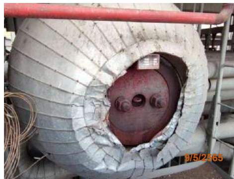
รูปที่ 2-55 Steam Drum ของหม้อไอน้ำ
