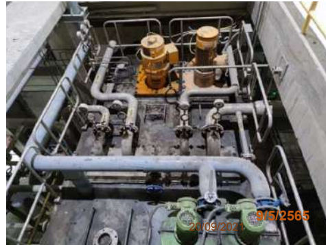
รูปที่ 2-67 DC Oil Pump ภายในโรงไฟฟ้า
