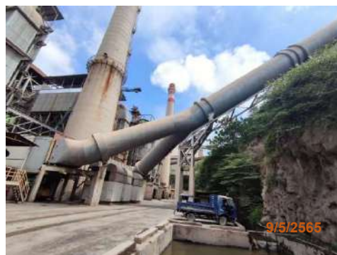
รูปที่ 2-39 ท่อลำเลียงลมร้อนในระบบปิด
